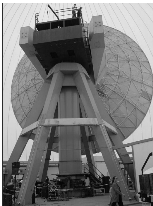
Die Antenne mit dem Turm und seinen Maschinenräumen.
